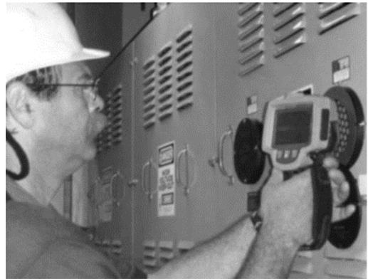
圖4 安裝紅外線檢測視窗可提高紅外線熱影像的檢測效率並降低對個人防護具使用的要求。
