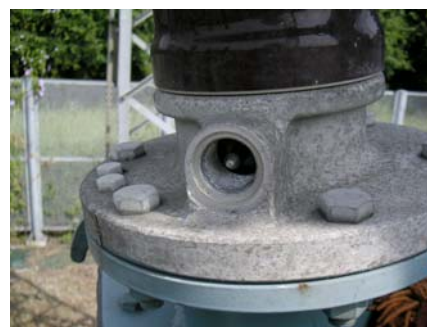
圖2 絕緣套管測試用分接頭
