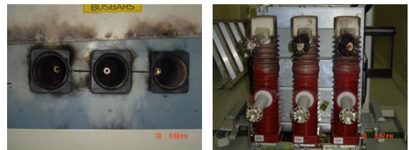
(a)固定接點端子 (b) 活動端子桿
